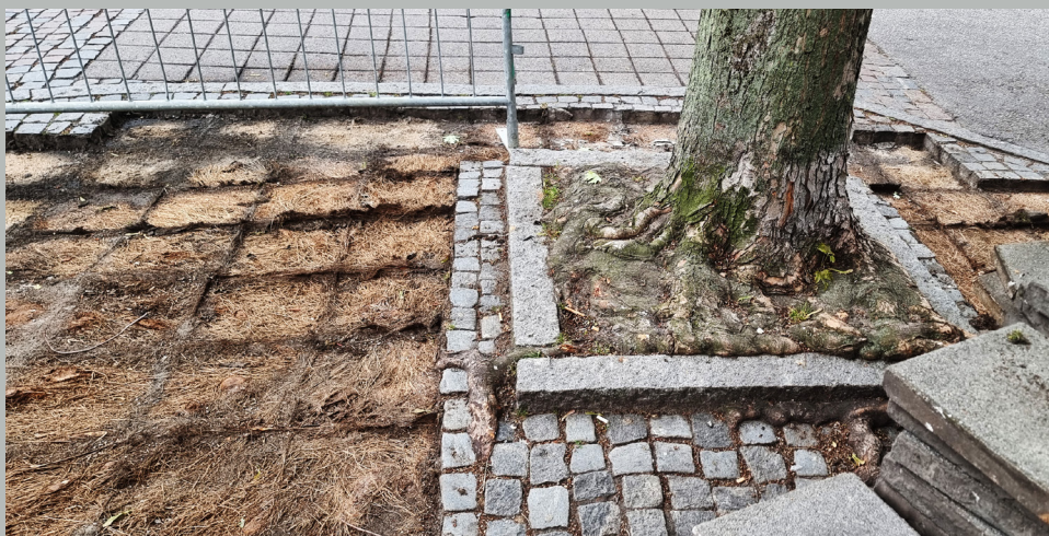
ibland kan rötternas utbredning kartläggas relativt enkelt, såsom här där en rät rotmassa återfanns direkt under betongplattorna. Foto: Gustav Nässlander
